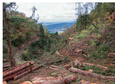
主伐現場の作業状況
