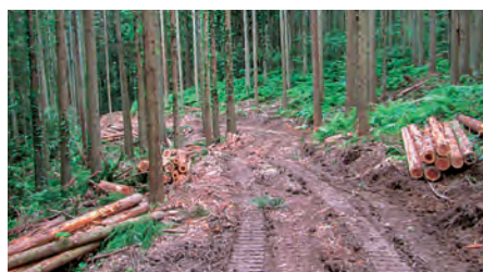
別山後谷地区での間伐作業
