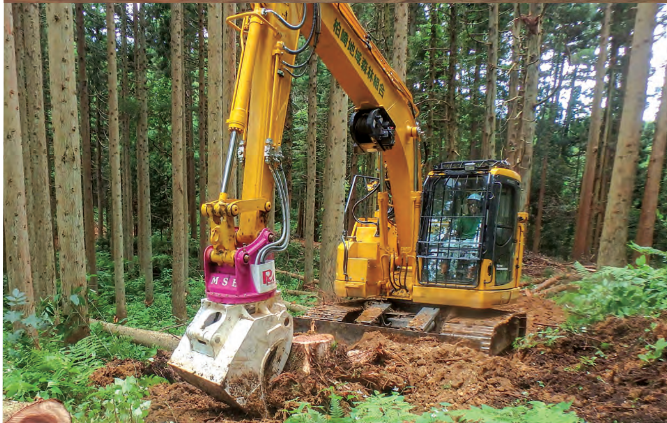
今春に導入した高性能林業機械 ザウルス・ロボ による森林作業道の開設状況(西山 別山後谷団地)
