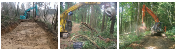
①作業道の開設
