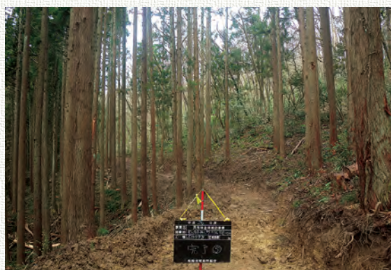
H26年度施工、別山後谷地区森林整備の完了状況
